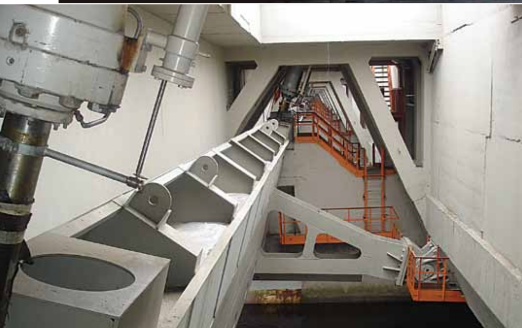
Jedna grupa segmentnih zatvarača
