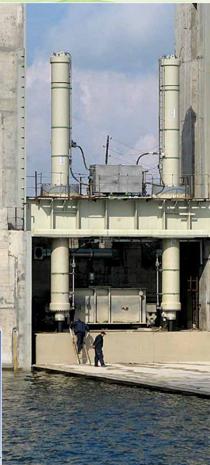
Upravljački blok za sinhronizaciju rada cilindara leve i desne strane zatvarača
