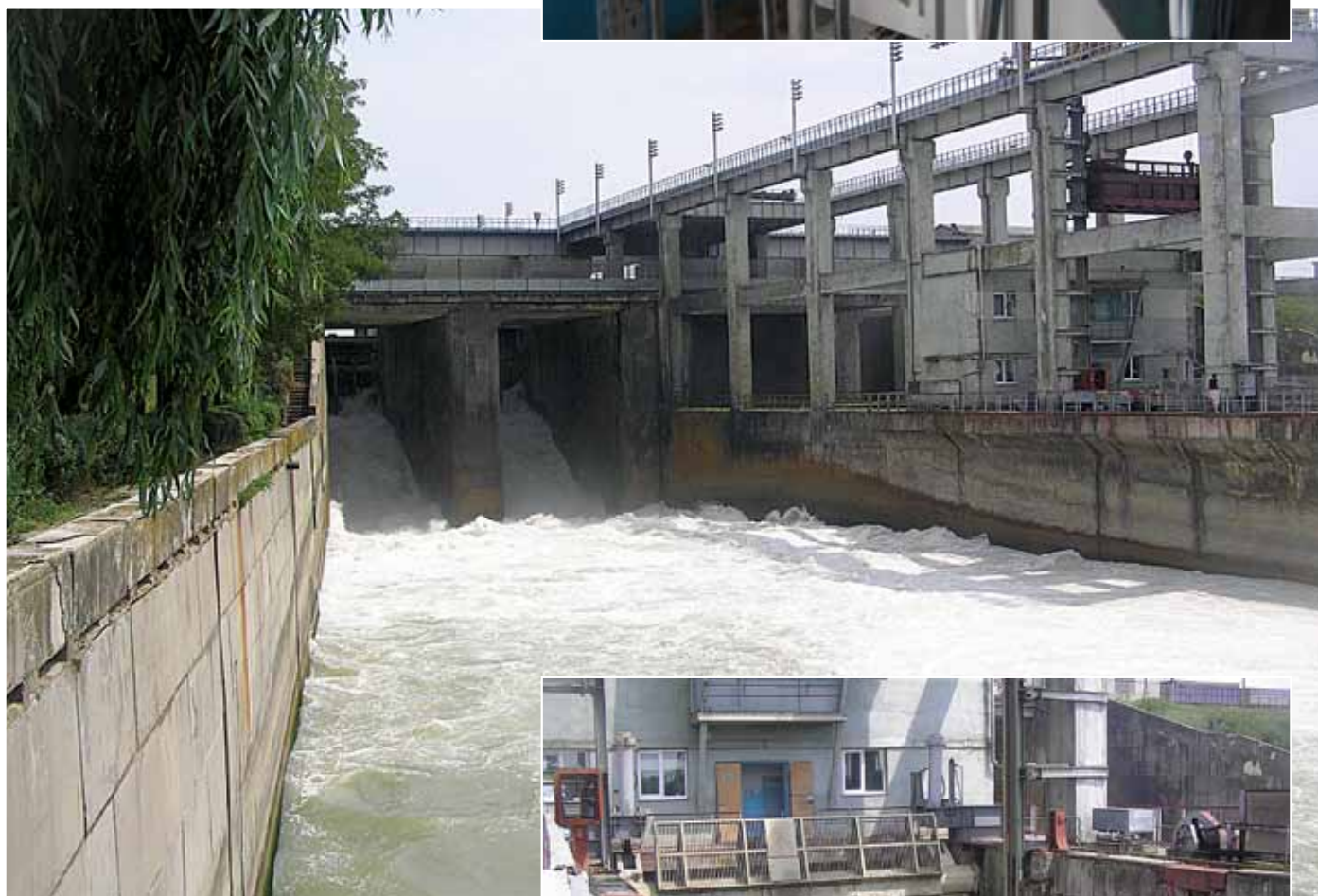
Первый и второй пролет водопропускного сооружения
