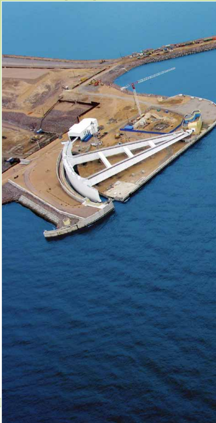
КЗС Санкт-Петербурга – сооружение С1, г. Санкт-Петербург, Россия
