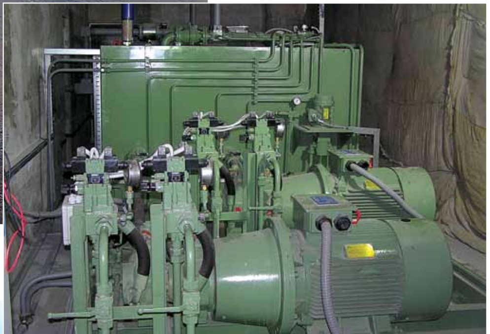
Гидравлический агрегат АРЗ
