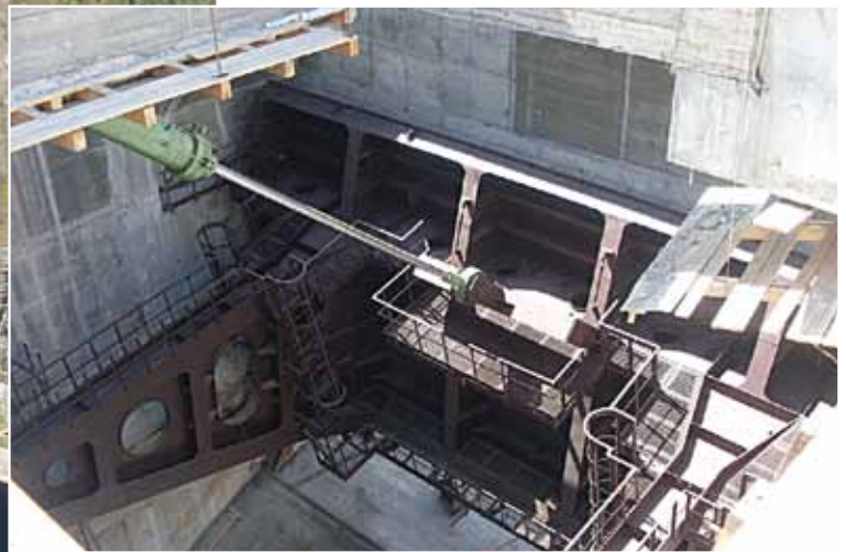
Цилиндр сегментного затвора водослива
