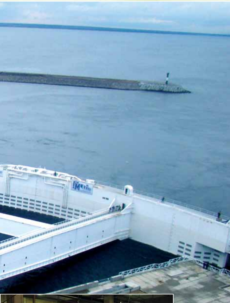
КЗС г. Санкт-Петербурга – секторный затвор - батопорт
