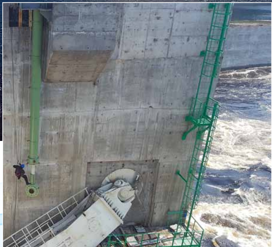
Цилиндр сегментного затвора
