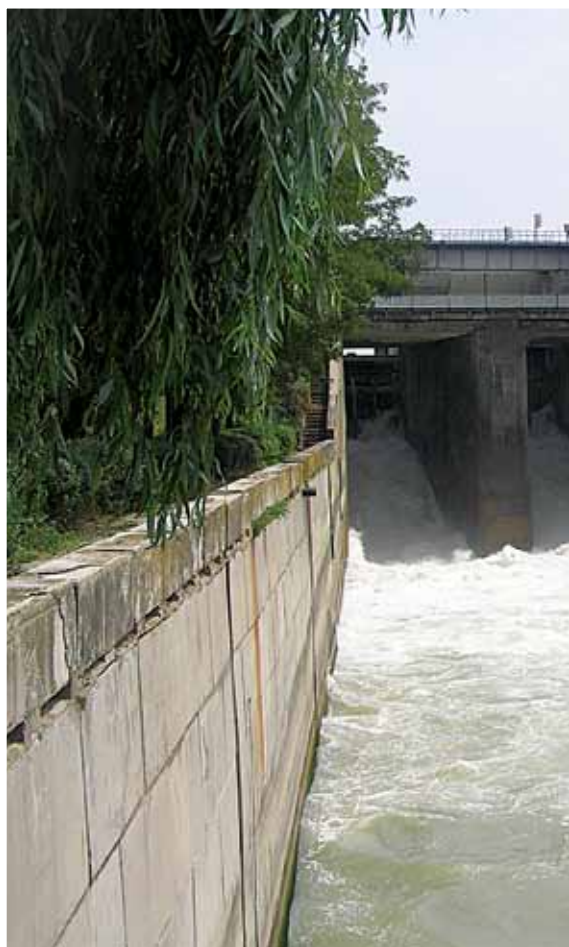
Первый и второй пролет водопропускного сооружения
