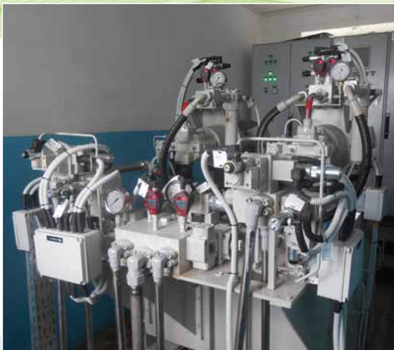
Блок управления сдвоенными крючкообразными затворами
