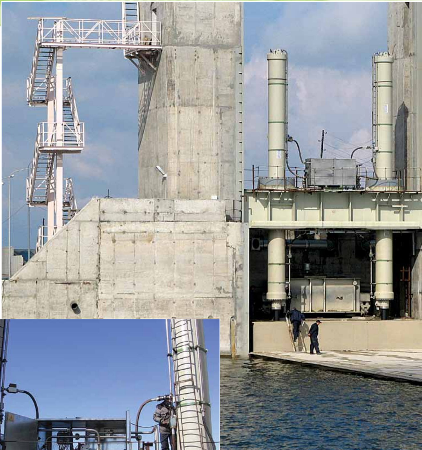
Блок управления для синхронизации работы цилиндра левой и правой сторон затвора
