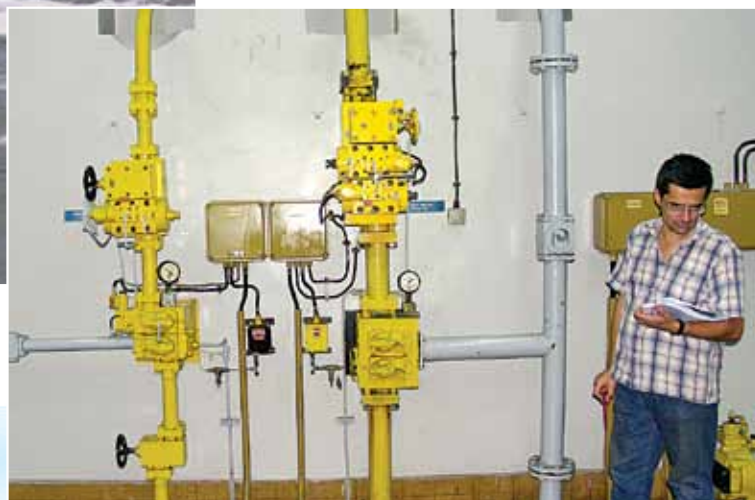
«Джердап-1» – Блоки управления на средней голове судоходного шлюза
