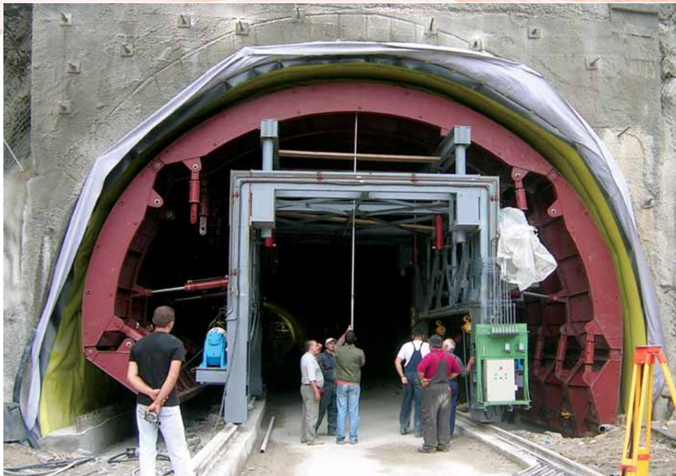
Гидравлическая телескопическая опалубка для бетонирования туннеля
