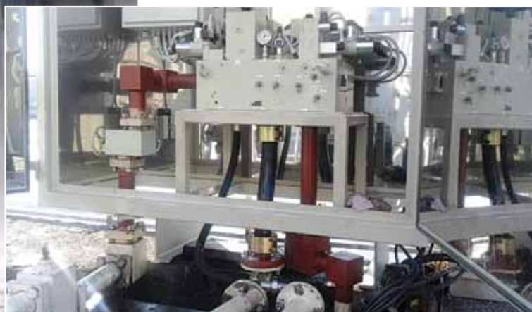
«Джердап-2» – Блок управления АРЗ
