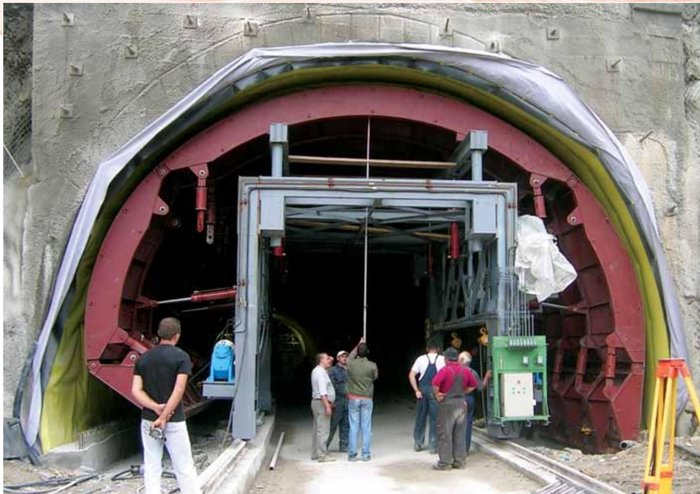
*Гидравлическая телескопическая опалубка для бетонирования туннеля*
