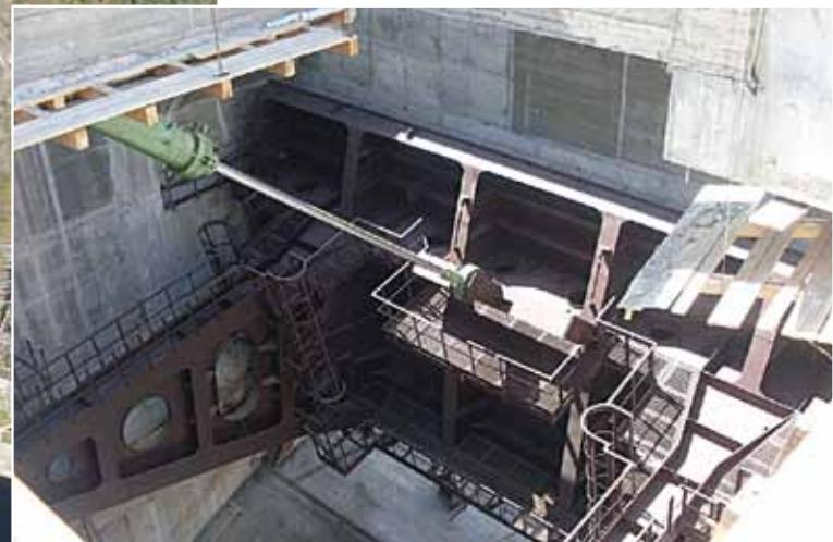
Cilindar segmentnog zatvarača prelivnog polja
